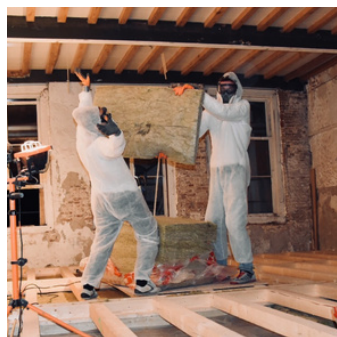
Wij isoleerden intussen de vloer
