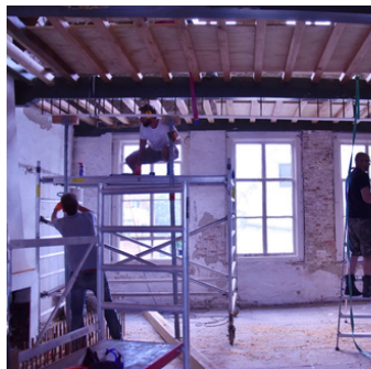
Moerbalken verstevigen met staal
